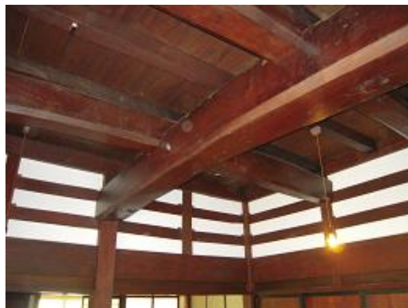
写真 12 移築前の旧畑島家住宅の梁組
